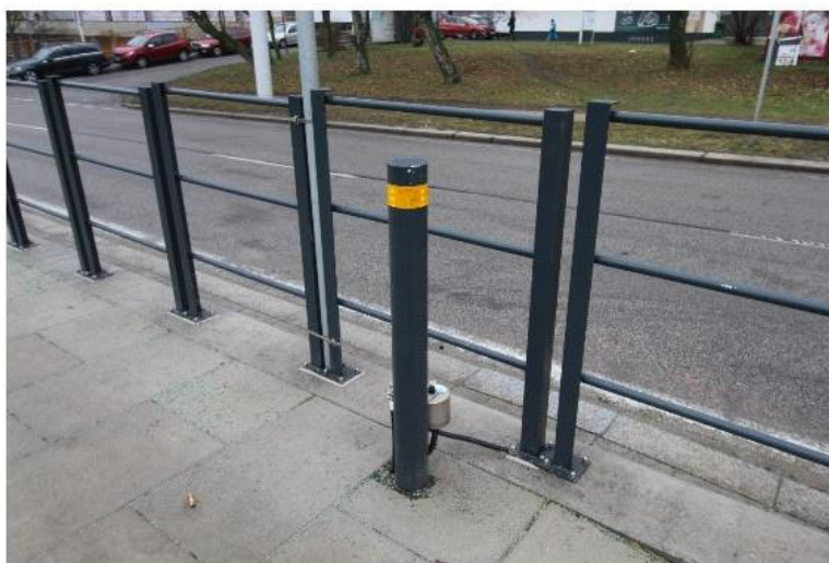
Obrázok 111_Príklad majáčka a nežiadúce riešenie ukoľajnenia
