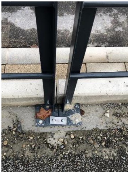
Obrázok 84_Příklad kotvení zábradlí pod povrchem dlažby - detail
