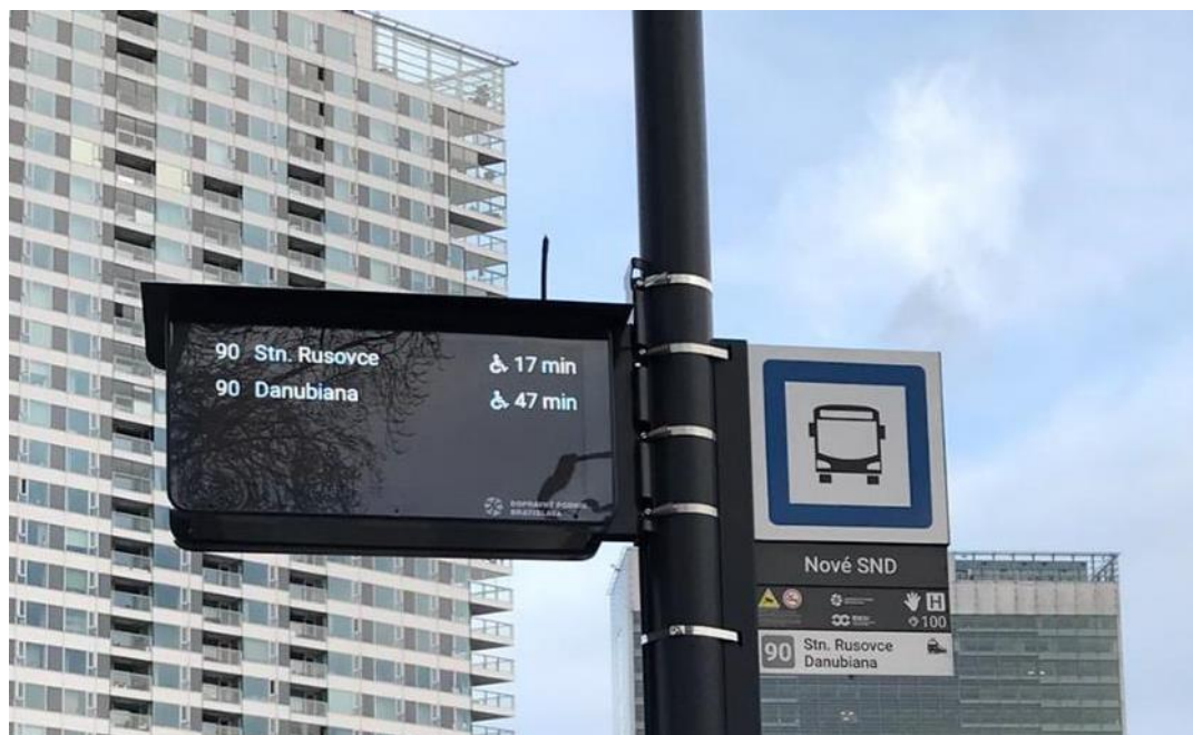
Obrázok 128_Príklad kotvenia EIT na existujúci stožiar na Olejkárskej ulici; upevňovacie pásky majú nevhodnú farebnosť - upevnenie musí byť riešené komponentmi vo farebnosti stožiara
