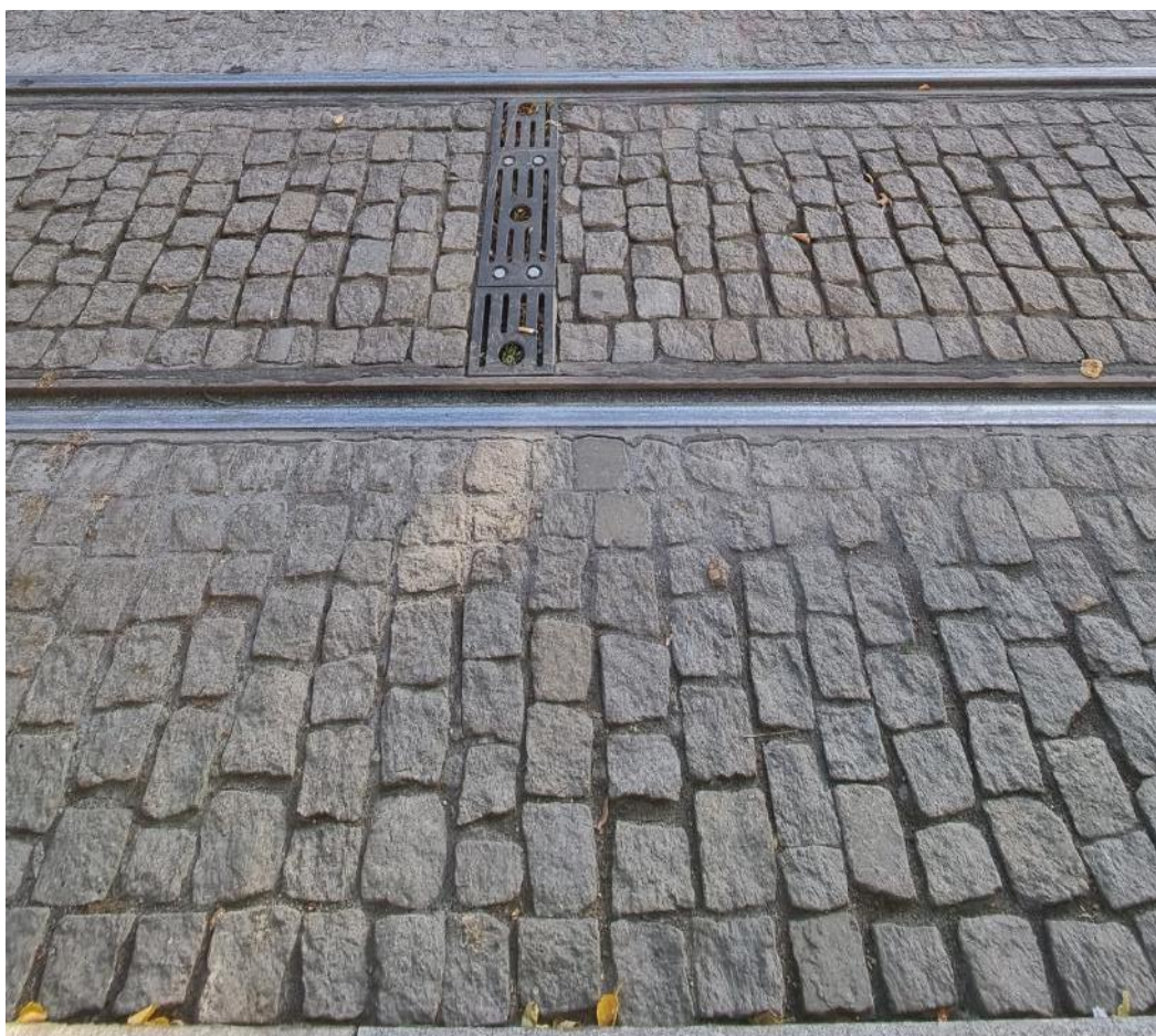
Obrázok 7_Príklad dláždenia koľajiska na jestvujúcej zastávke Americké námestie; stredná štiepaná dlažbová kocka
